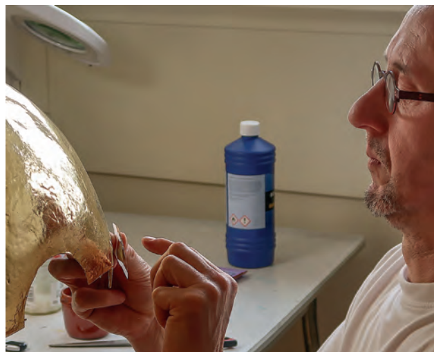
Jos Loonen brengt bladgoud aan op een helft van de bol van de kerktoeren in Swalmen.
