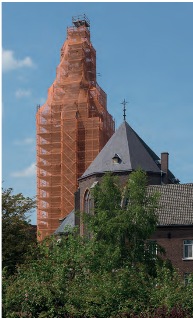
De toren van de St. Lambertuskerk in Swalmen staat voor renovatiewerkzaamheden in de steigers (Foto Peter Bors)
