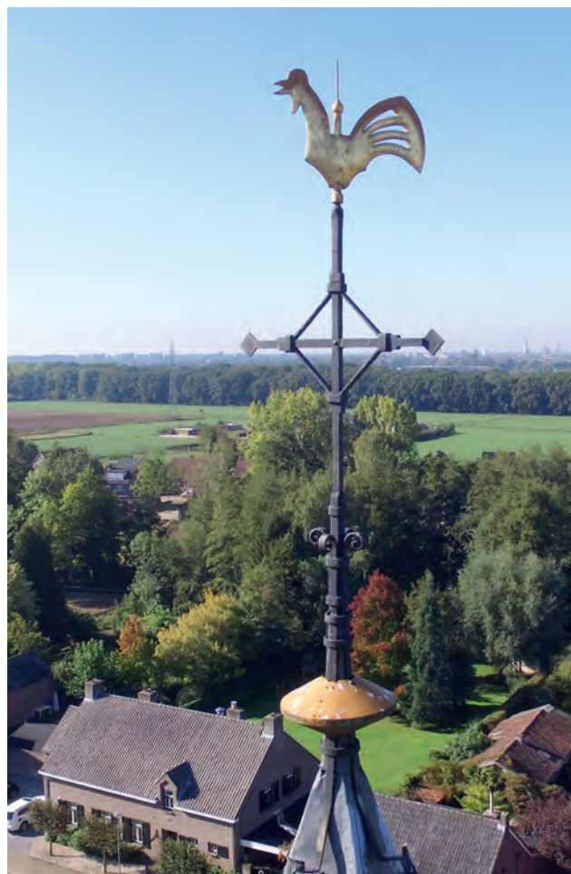
In Boukoul is de bol op de toren van de Sint-Theresia van het Kind Jezuskerk afgeplat. De pin op de rug van de haan is een bliksemafleider. Boven de bol klemmen ijzeren ringen het begin van de ‘veren’ tegen de staaf van het smeedijzeren kruis. (Foto Erik Smeets)
